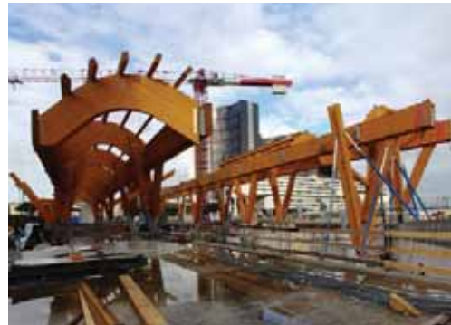
مترو ستيشن - زرقية (محطة وجسر تحت الإنشاء)
